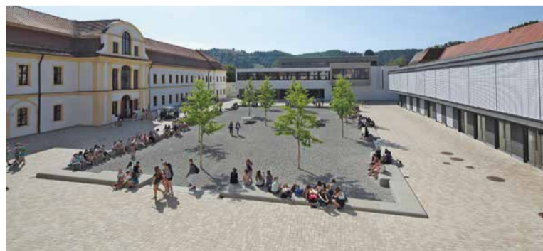
Das TEGULA®-Pflaster mit seinen gebrochenen Kanten verbindet harmonisch das historische Kloster und die modernen Schulgebäude.
